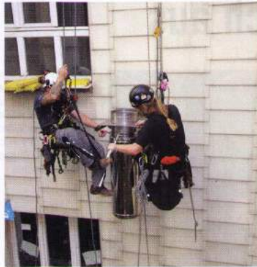
Bild 3 Montage des Abgasrohrs für die Notstromver- sorgung
