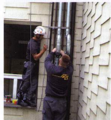
Bild 2 Montage der Wasserleitung für die Motorkühlung des Notstrom-Aggregats
